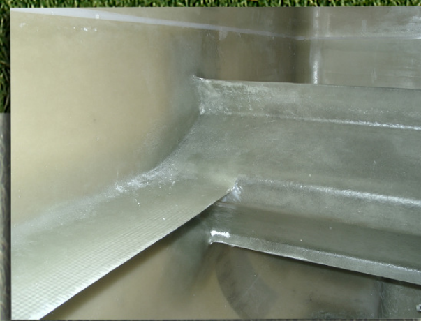
стенки, препятствующие образованию волн в баке; гладкая поверхность
